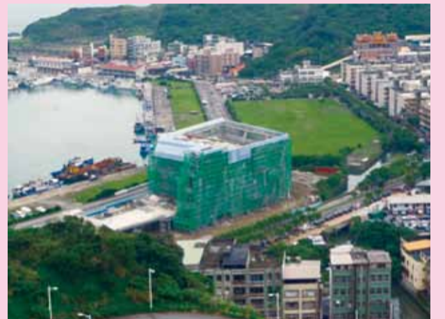
區域探索館 11 月工地現況
