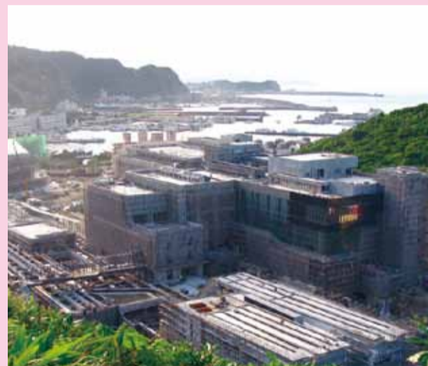
主題館工程9月工地現況
