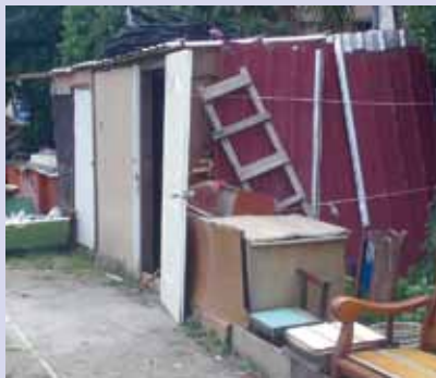
原屬於大眾使用的綠地，被少數人佔用，嚴重破壞了地區的整體環境美感。 攝影／李建筠
